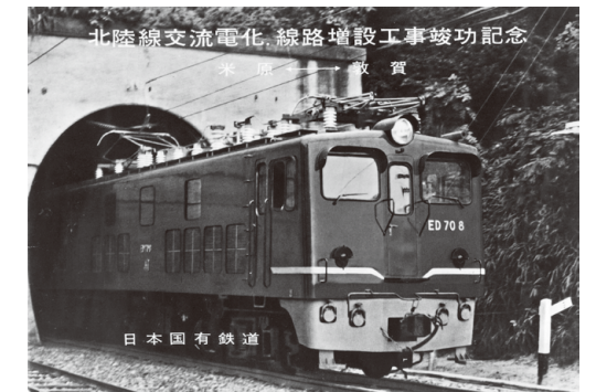
▲日本国有鉄道 北陸線交流電化 線路増設工事竣工記念
